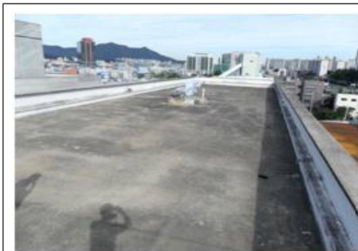
[사진2] 옥상 바닥 상태
